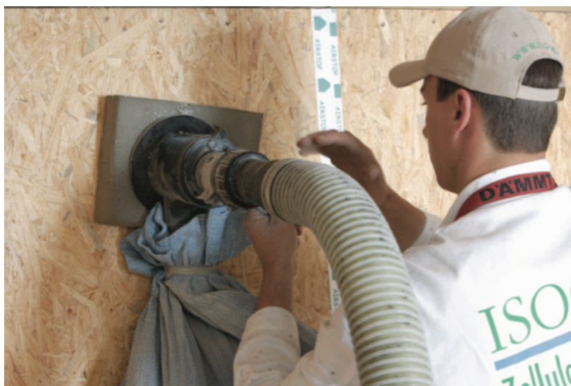
pav. 4: Į medinio rėmo sieną įpurškiama celiuliozė (šaltinis: „Isocell GmbH“).
