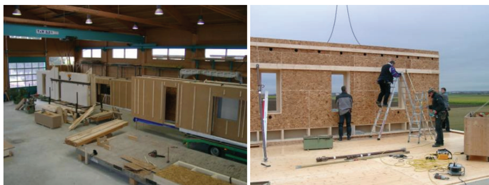
pav. 7: Iš anksto pagaminami ir surenkami fasado elementai (šaltinis: „Augsburger Holzhaus GmbH“)
