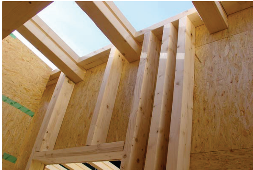
pav. 2: Medinė karkasinė-rėminė konstrukcija (šaltinis: Holka Genossenschaft)
