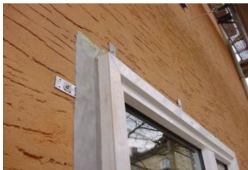
Obr. 18: Izolace okolo okenního rámu pro minimalizaci tepelných ztrát (zdroj: Schulze Darup)
