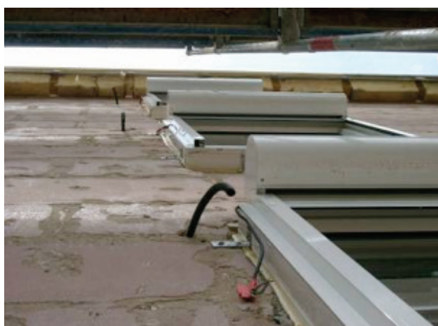
Obr. 17: Okna osazovaná v průběhu renovace (zdroj: Schulze Darup)
