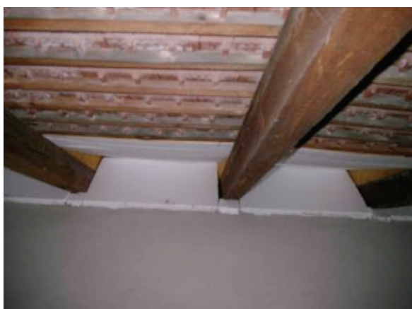
Obr. 13: Izolace trámového stropu (zdroj: Schulze Darup)
