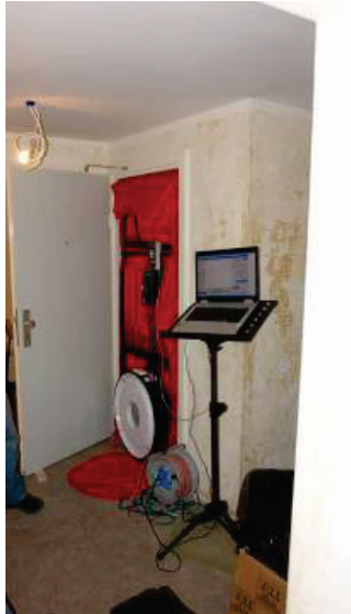
Obr. 22: Zkouška těsnosti – „blower door test“ (zdroj: Schulze Darup)
