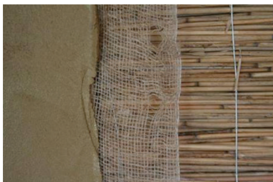
Obr. 7: Rákos a vápenná omítka mohou být použité u vnitřních izolací, protože umožňují difúzi (zdroj: GrAT)
