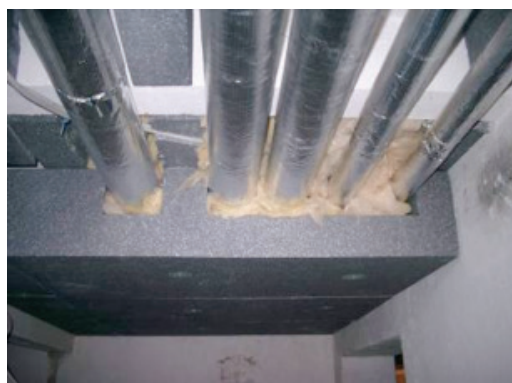
Figura 14: un soffitto dell'interrato isolato dal basso. Qui i tubi sono inseriti nello strato isolante, vale a dire isolati all'interno dell'involucro edilizio (fonte: Schulze Darup)
