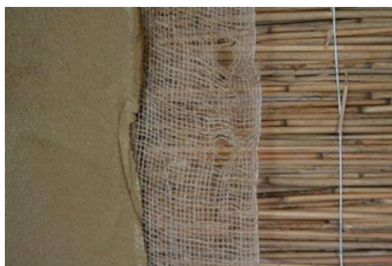
Figura 7: isolamento con canne palustri e intonaco di calce usati come isolante permeabile (fonte: GrAT)
