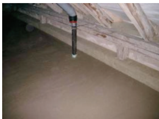
Figura 12: massetto sopra l'isolante del solaio del sottotetto (fonte: Schulze Darup)
