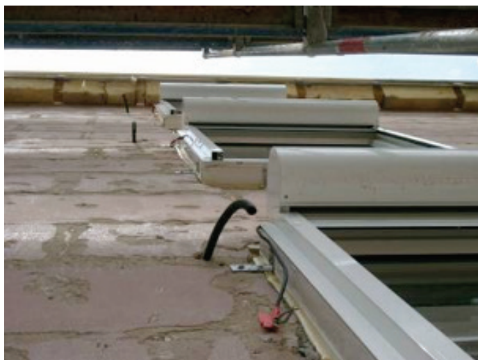
Figura 17: installazione di serramenti in fase di ristrutturazione (fonte: Schulze Darup)
