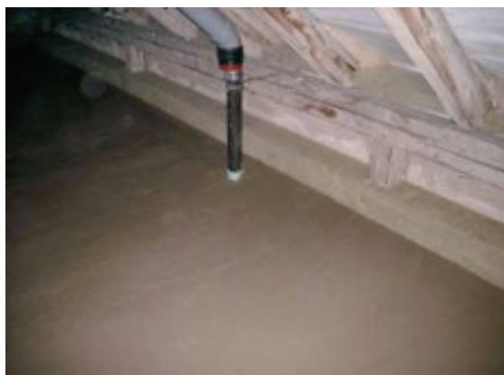
Ilustracja 12: Wylewka powyżej izolacji stropu najwyższej kondygnacji (źródło: Schulze Darup)
