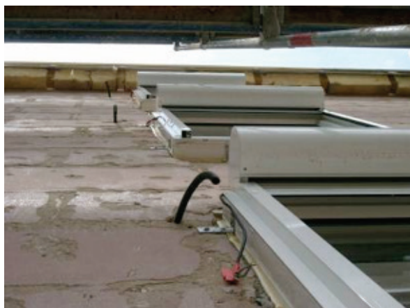
Ilustracja 17: Okna instalowane w trakcie renowacji (źródło: Schulze Darup)
