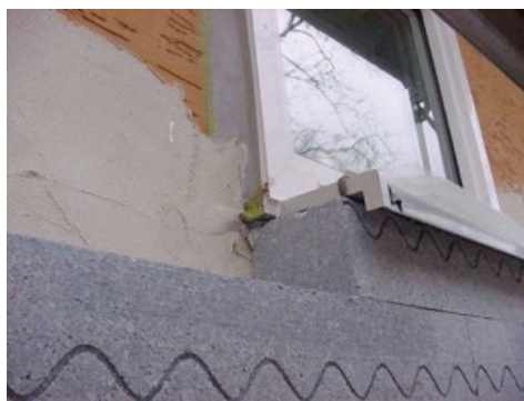
Ilustracja 5: Spoiny pomiędzy zewnętrzną izolacją a oknami muszą być wykonane starannie (źródło: Schulze Darup)
