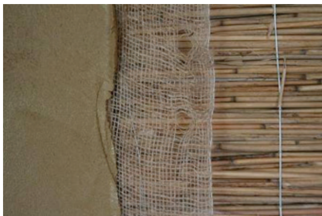
Ilustracja 7: trzcina i tynk wapienny mogą zostać zastosowane do izolacji wewnętrznej otwartej na dyfuzję (źródło: GrAT)
