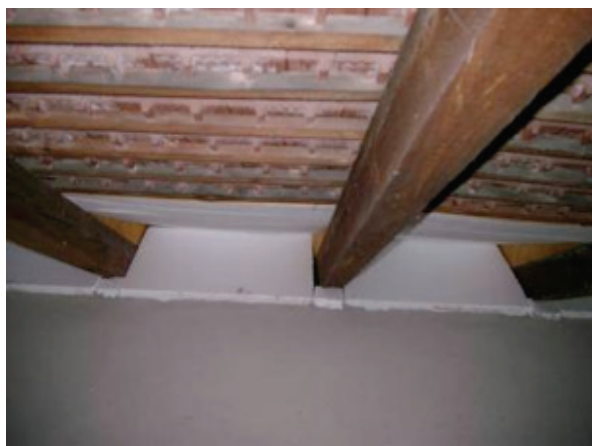
Ilustracja 13: Izolacja drewnianego stropu (źródło: Schulze Darup)
