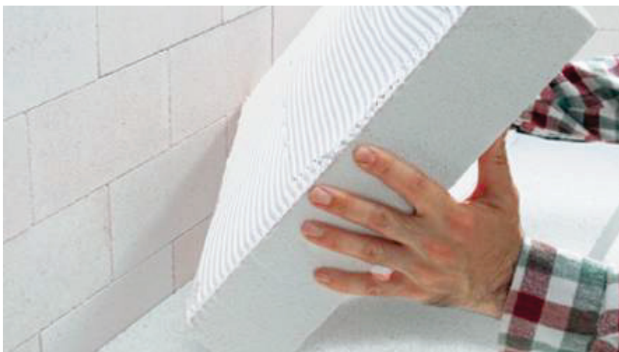
Obr. 4: Pěnový minerální panel pro kompozitní zateplovací systém (zdroj: Dennert)
