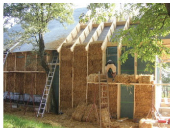
Obr. 18: Zabudování slaměné izolace (zdroj: GrAT)
