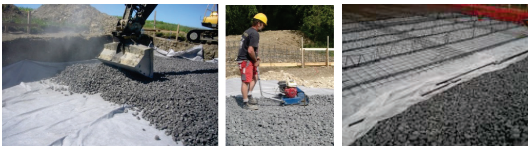
Obr. 11: Příklad použití drtě z pěnového skla (zdroj: GEOCELL Schaumglas GmbH)
