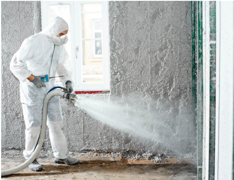
Obr. 26: Nástřik celulózy při vnitřní izolaci (zdroj: Isocell GmbH)
