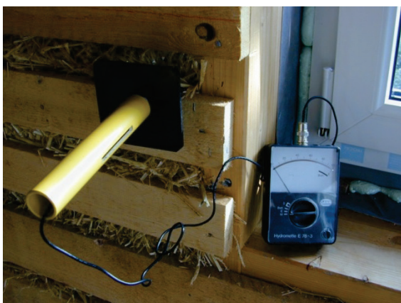
Obr. 20: Měření vlhkosti slámy po jejím zabudování (zdroj: GrAT)
