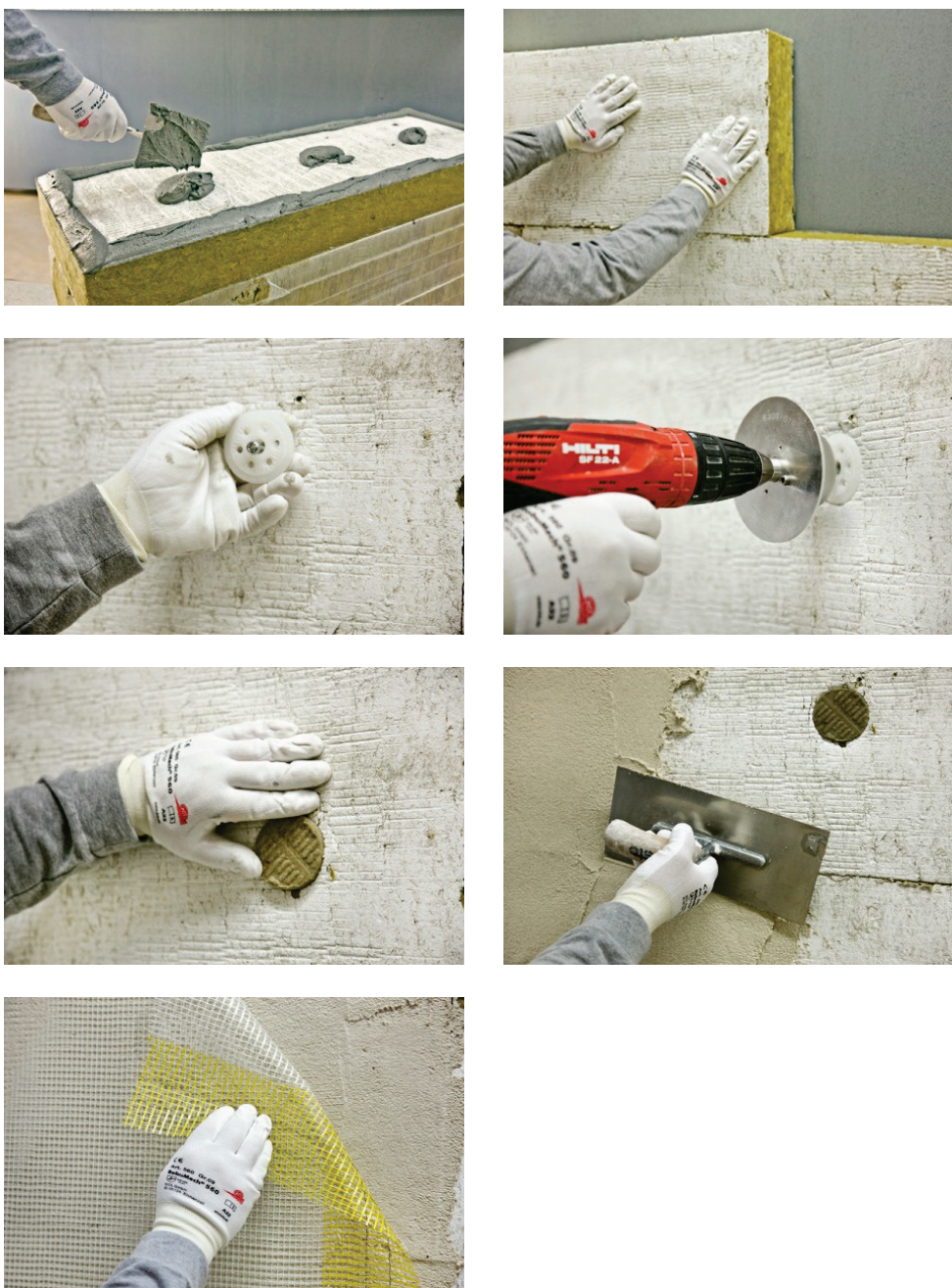
Obr. 3: Příklad použití desek z minerální vlny (zdroj: Sto SE & Co. KGaA)
