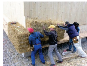
Obr. 19: Zabudování izolace ze slámy do objektu S-HOUSE v Böhheimkirchenu (zdroj: GrAT)
