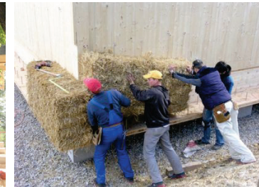
pav. 20 Šiaudų izoliacijos įrengimas S-HOUSE žemutinėje Austrijoje (šaltinis: GrAT)
