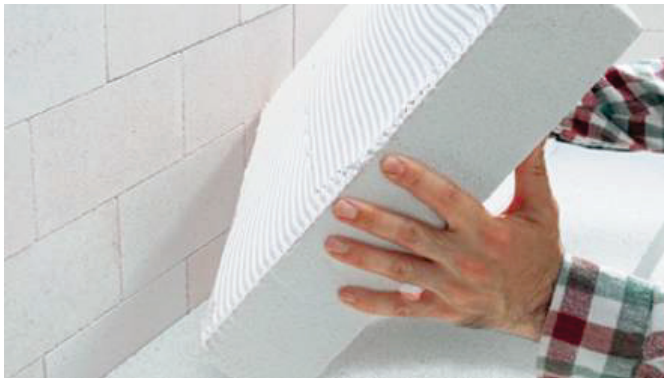
pav. 4: Mineralinės vatos plokštė naudojama sudėtinei termoizoliacinei sistemai (šaltinis: Dennert)
