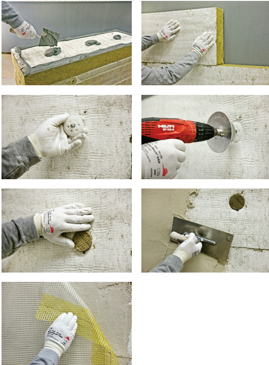
pav. 3: Mineralinės vatos plokščių tvirtinimas (šaltinis: Sto SE & Co. KGaA)
