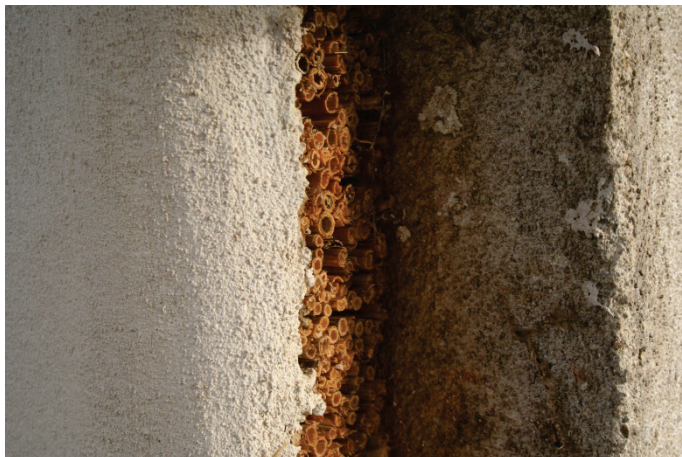
pav. 22: Kalkių tinku padengta nendrių plokštė (kairėje) nendrių granuliu plokštė (dešinėje) (šaltinis: GrAT)
