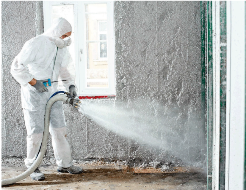
pav. 27: Celiuliozės įpurškimas vidaus izoliacijai (šaltinis: Isocell GmbH)
