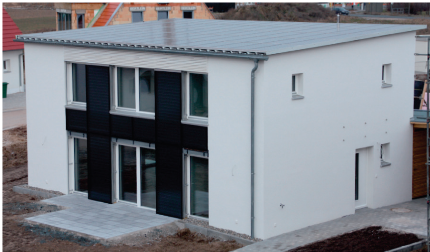
Obr. 2: Příklad budovy s „téměř nulovou spotřebou energie“: budova s fotovoltaickým systémem na střeše a solárním systémem na čelní fasádě (zdroj: Arch Wimmer - Schulze darup & partner)
