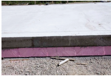
Obr. 4: Podlahová deska s izolační vrstvou (zdroj: Arch Wimmer - Schulze darup & partner)
