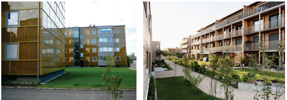
Obr. 8 a Obr. 9: Vlevo pasivní dům v Rakousku se solární fasádou (zdroj: Michael Paula, bmvit); vpravo je sídliště SunnyWatt ve Švýcarsku, podle normy Minergie-P-Eco (zdroj: kämpfen für architekturag)
