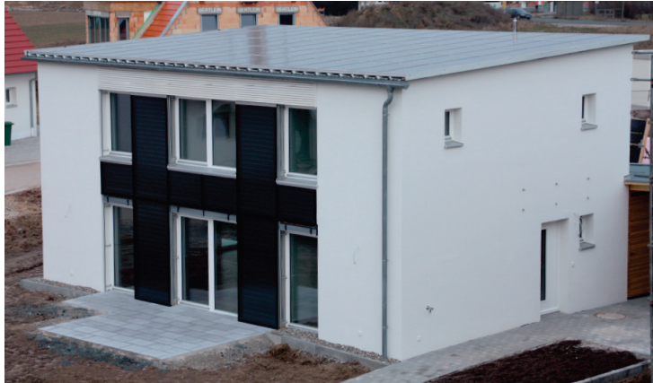
Figura 2: Esempio di un edificio ad “Energia Quasi Zero” con sistema fotovoltaico sul tetto e sistema di pannelli solari sulla facciata frontale (fonte: Arch Wimmer – schulze darup & partner)
