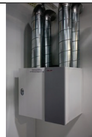
Figura 7: Sistema di ventilazione controllata con recupero di calore (fonte: Bin im Garten; https://upload.wikimedia.org/wikipedia/commons/2/22/IFA_2010_Internationale_Funkausstellung_Berlin_104.JPG )
