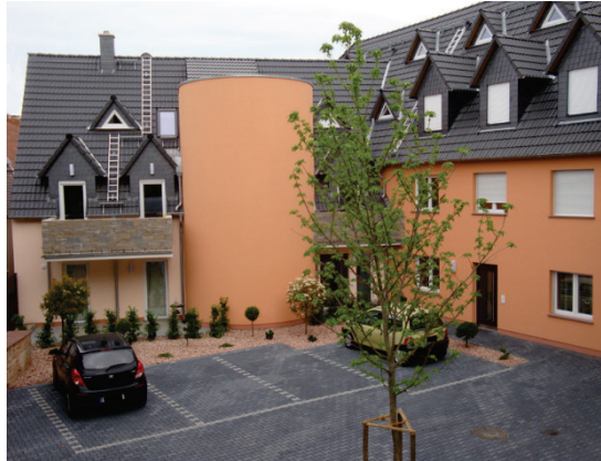
pav. 11: Saulės namas su įrengtu šilumos kaupikliu (šaltinis: Andol; http://commons.wikimedia.org/wiki/File:Solarhauskomplex_mit_Solartank.png#/media/File:Solarhauskomplex_mit_Solartank.png )
