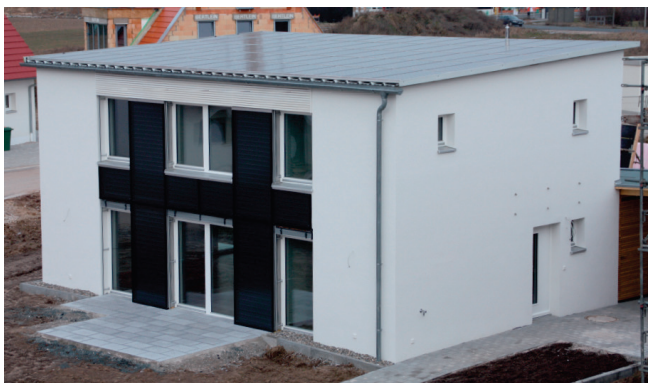
pav. 2: "Energijos beveik nevartojančio pastato" pavyzdys, kuriame įrengta fotovoltinė sistema ant stogo ir saulės šiluminė sistema ant priekinio fasado (šaltinis: Arch Wimmer – schulze darup & partner)
