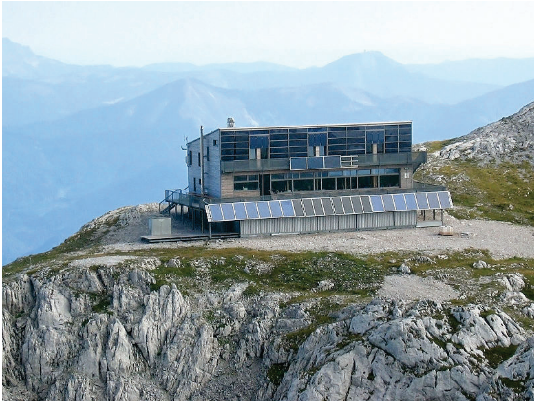
pav. 9: „Schiestlhaus“ – pirmasis aukštai kalnuose pastatytas pasyvusis namas (šaltinis: Michael Schmid; http://commons.wikimedia.org/wiki/File:Schiestlhaus_Jul2007.jpg#/media/File:Schiestlhaus_Jul2007.jpg )
