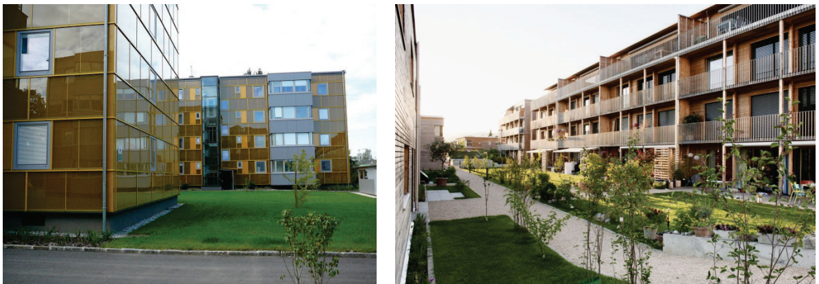
pav. 8: kairėje: saulės kolektorių fasado pasyvus namas Austrijoje (šaltinis: Michael Paula, bmvit); dešinėje: SunnyWatt gyvenamasis kvartalas Šveicarijoje, atitinkantis Minergie-P-Eco standartą (šaltinis: kämpfen für architekturag)
