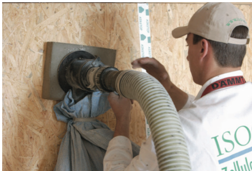
Obr. 4: injektáž celulózy do prostor dřevěného rámu (zdroj: Isocell GmbH)
