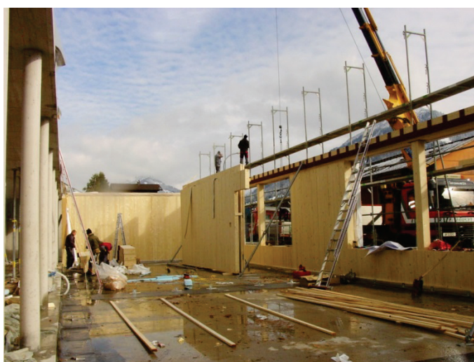
Obr. 10: Kolíkové prkenné prvky (zdroj: Bruno Spagolla)
