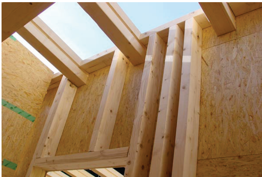
Obr. 2: Rámová trámová struktura (zdroj: Holka Genossenschaft)
