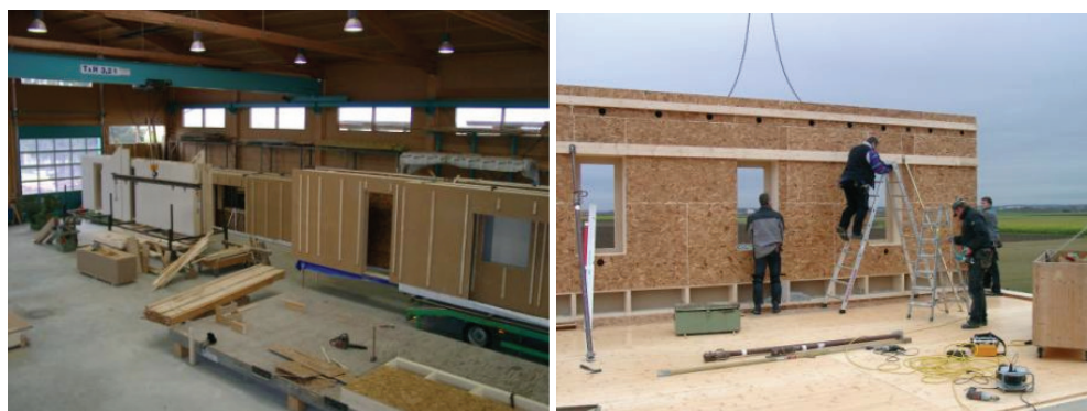
Obr. 7: Výroba a montáž prefabrikovaných fasádních prvků (zdroj: Augsburg Holzhaus GmbH)
