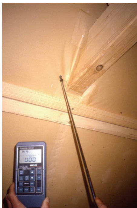
Obr. 15: Měření těsnosti v místech průniku trámy konstrukcí a střešního pláště. (zdroj: Schulze Darup)
