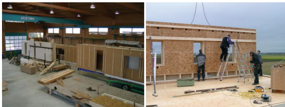
Ilustracja 7: Produkcja oraz instalowanie elementów fasady (źródło: Augsburg Holzhaus GmbH)
