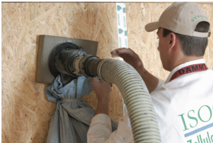
Ilustracja 4: Wstrzykiwanie celulozy (źródło: Isocell GmbH)
