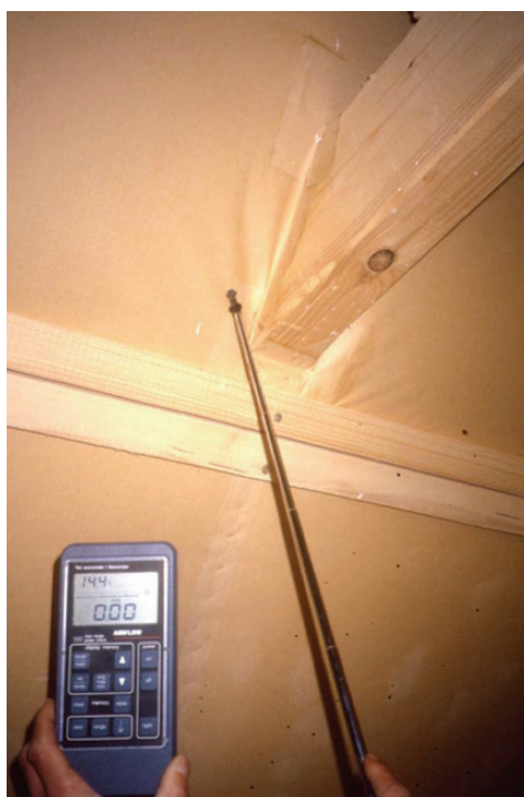
Ilustracja 15: Pomiar nieszczelności dachu (źródło: Schulze Darup)
