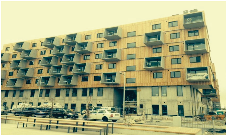
Obr. 6: Vnější stěnový systém s dřevěným opláštěním v Seestadt Aspern, Vídeň, Rakousko (zdroj: Weissenseer Holz-System-Bau GmbH)
