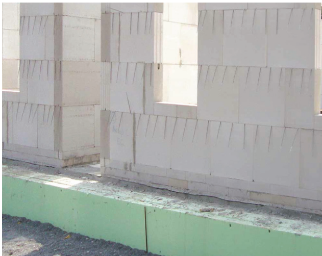
Obr. 17: Vnitřní vrstva zdiva s kotvami pro upevnění vnější, lícové vrstvy zdiva (zdroj: Schulze Darup)
