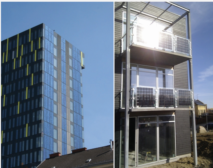
Obr. 22: Solární moduly jsou začleněny do fasády (vlevo) a do balkonového zábradlí (vpravo) (zdroj: Fa Ertex Solar)
