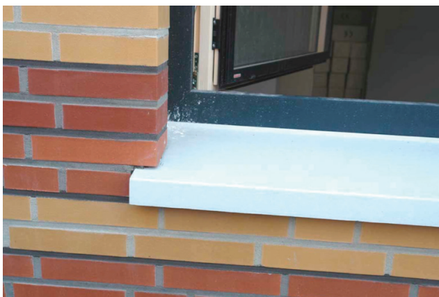
Obr. 18: Fasádní (lícové) zdivo v okolí okna. Pod ním je umístěna 20 cm tlustá vrstva izolace se součinitelem \lambda = 0,025 \text{ W/mK} a hodnotou U_{0,12} \text{ W/m}^2\text{K} (zdroj: Schulze Darup)
