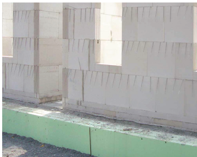
Ilustracja 18: Ściana z kotwami (źródło: Schulze Darup)
