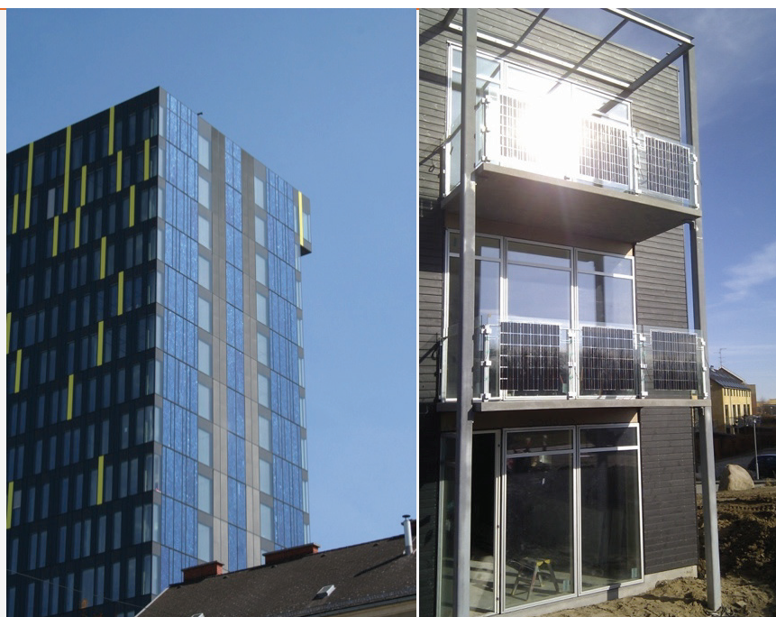
Ilustracja 23: Panele słoneczne zintegrowane z fasadą budynku (po lewej stronie) oraz z częścią balkonów (po prawej) (źródło: Fa. Ertex Solar)
