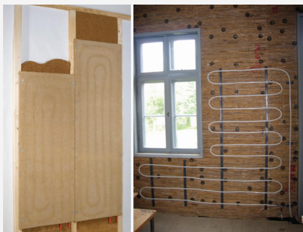
Obr. 2 (vlevo): Stěnové vytápění v montovaném stavebním dílu z jílů v kombinaci s vláknitou izolační deskou z měkkého dřeva („hobra“), provedené tzv. suchou montáží - připevněním na nosnou konstrukci (zdroj: WEM Wandheizung GmbH)
