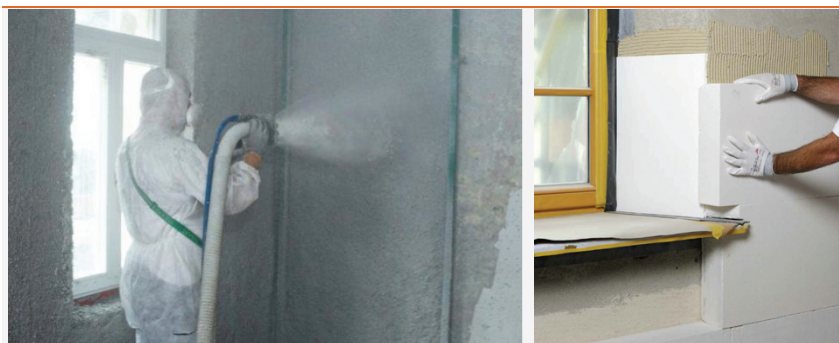
Obr. 4 (vlevo): Aplikace vnitřního izolačního systému ze stříkané celulózy. Vhodné zejména u nerovných povrchů (zdroj: Isocell GmbH)
