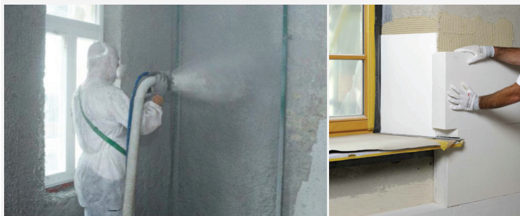
pav. 4 (kairėje). Įrengiama vidaus izoliacinė sistema purškiant celiuliozę, rekomenduotina nelygiems paviršiams (šaltinis: Isocell GmbH)
