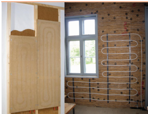
Ilustracja 2 (lewa strona): Ogrzewanie ściienne z panelem izolacyjnym z miękkiego drewna (źródło: WEM Wandheizung GmbH)
