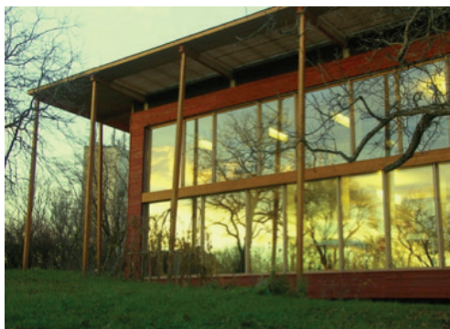
Obr. 13: Skleněná jižní fasáda (zdroj: GrAT)
