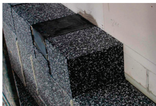
Obr. 9: Izolace ETICS v místě připraveném pro uchycení osvětlovacího tělesa (zdroj: Schulze Darup)
