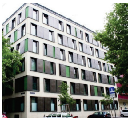
Obr. 16: Studentská kolej ve Vídni (zdroj: GrAT)
