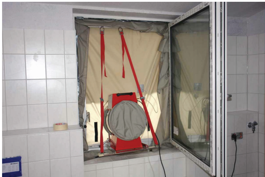
Obr. 23: Měření tlakovým ventilátorem – v tomto případě je umístěn v místě okenního otvoru, protože u domovních dveří se pravděpodobně prokázala existence velkých nerovností a netěsností (zdroj: Schulze Darup)
