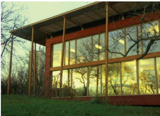
Figura 12: Facciata sud vetrata (fonte: GrAT)
