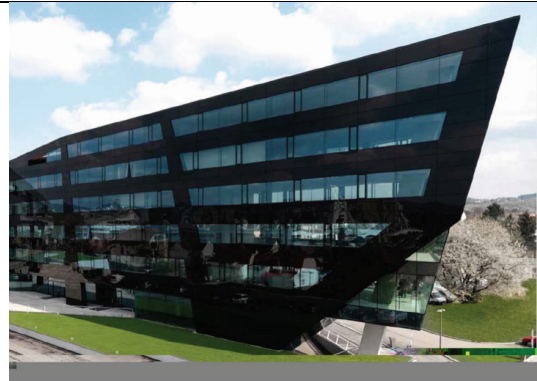
Figura 9: "Schwarzer Panther" ("Pantera Nera"), Graz, Austria, architetti: GSarchitects Graz. Facciata continua nella forma di facciata in vetro (fonte: STO)
