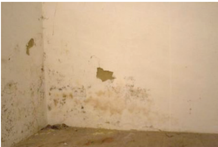
Figura 16: viluppo di muffe negli angoli in cui vi sono ponti termici (fonte: GrAT)
