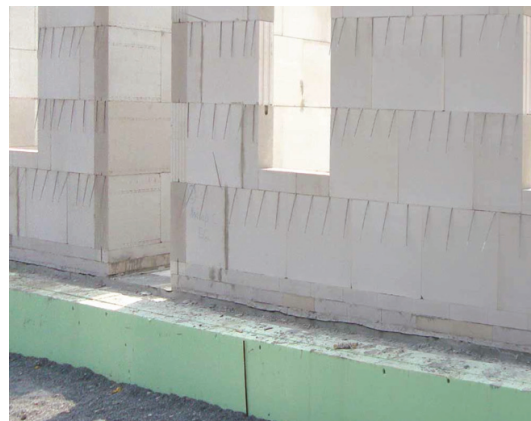
pav. 12: Vidinis mūro apvalkalasu ankeriais fasado apvalkalui (šaltinis: Schulze Darup)
