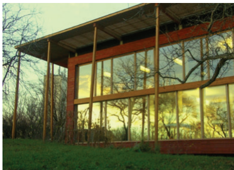
pav. 13: Stiklinis pietų pusės fasadas (šaltinis: GrAT)
