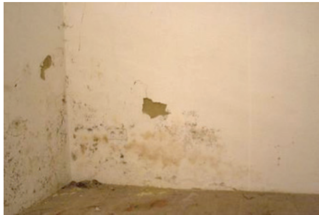
pav. 18: Pelėsio susidarymas kampuose, kur formuojasi šalčio tiltai (šaltinis: GrAT)
