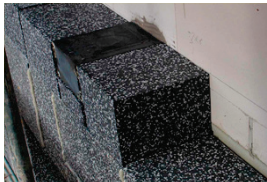
pav. 9: ISTS su ankeriais apšvietimui (įrengiama šalčio tilto poveikiui sumažinti) (šaltinis: Schulze Darup)
