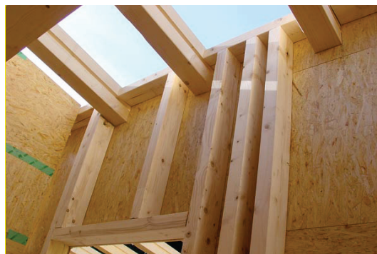
pav. 7: Medinė karkasinė-rėminė konstrukcija (šaltinis: Holka Genossenschaft)
